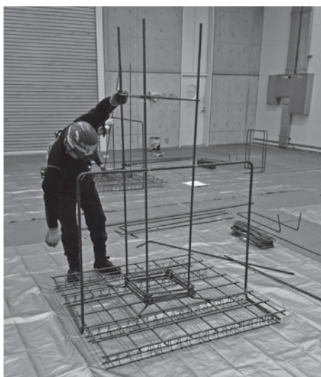
随時3級 鉄筋組立て作業
